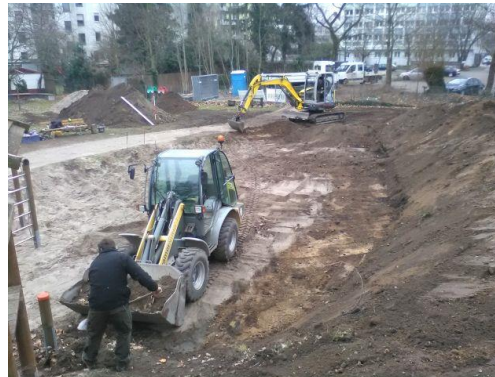
Startschuss für die Bagger am 06.02.2018
